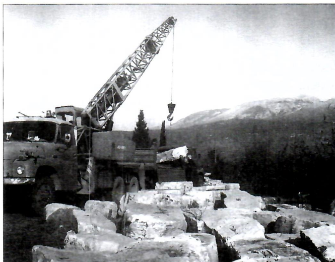
Sl. 5. Prijenos i zaštita stećaka s nekropole Vituša kod brane HE Salakovac na Neretvi (Foto: Č. Raič).
