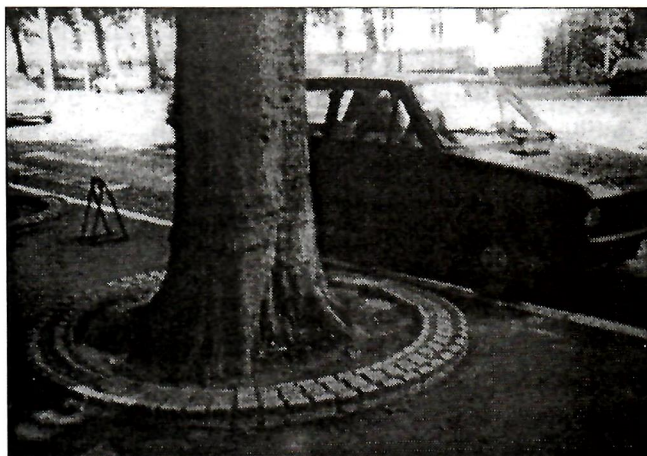
Sl. 10. Otvor za sadnice oivičen montažnim behaton elementima.
