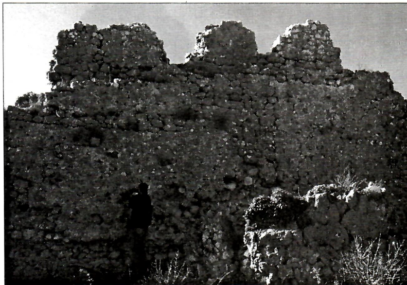
Sl. 4. Dio zida Z1.
