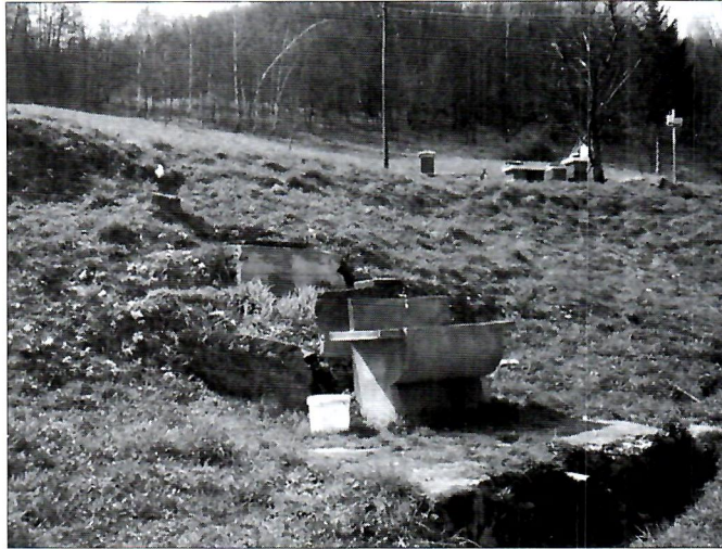
Sl. 2. Kaptirani izvor u blizini ulaznog portala tunela.
