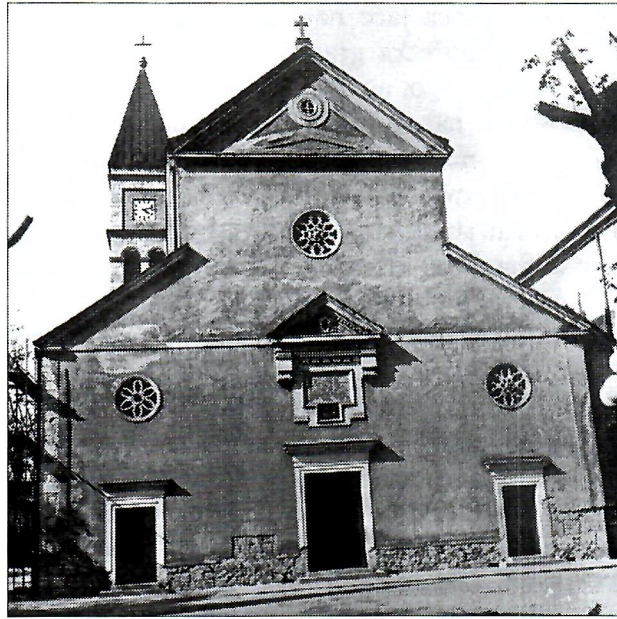
Sl. 1. Izgled pročelja na početku obnove.
