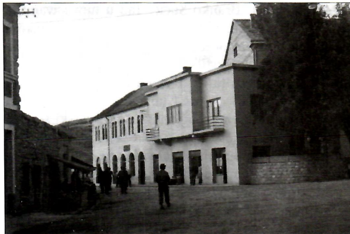
Sl. 18. Neposredno nakon rata – desno u prvom planu kuća Nikice Tadića i do nje Bailova–Deldumova–Radetina; preko puta porušena Kujundžićeva.
