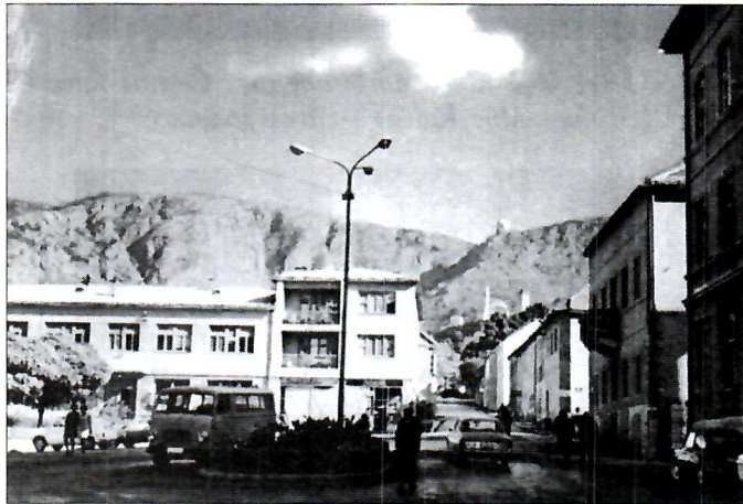
Sl. 17. Zgrada Pošte na mjestu Čevrine i Kaića kuće – treća kuća desno Gasalova (bivša Kujundžićeva) smanjena za jedan kat (snimka iz 1970.).
