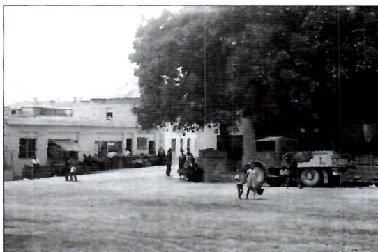
Sl. 14. U nedovršenoj Pervanovoj kući improvizirane prodavaonice nakon rata – desno kestenom zaklonjena kuća Nikice Tadića.
