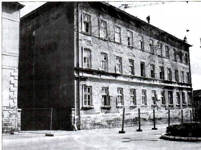
Sl. 2. "Konak" u tijeku obnove (snimljeno 17. 4. 2009.).
