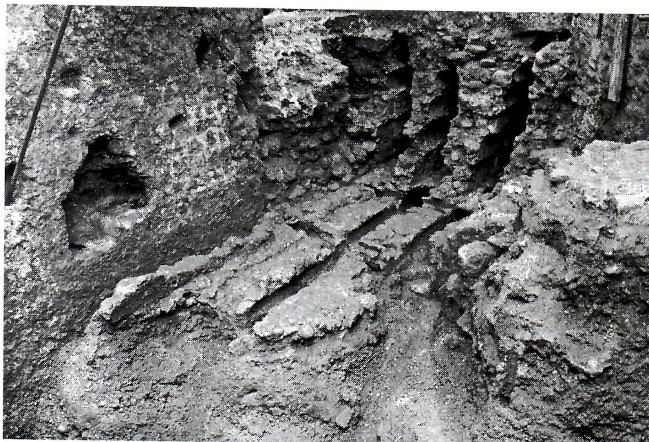
Sl. 5. Pogled na iskop 1 i konstrukciju drvenog mosta na lijevoj obali.
