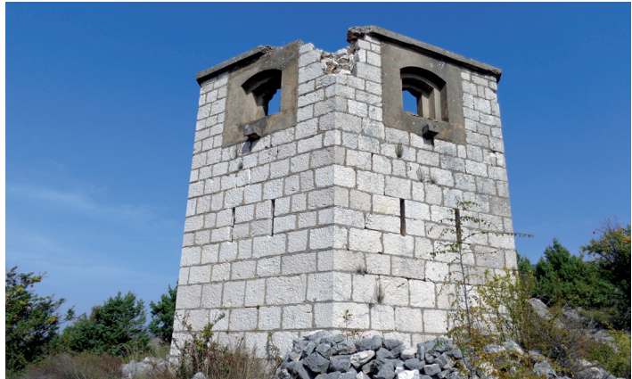
Stražarska utvrda Komanje Brdo
